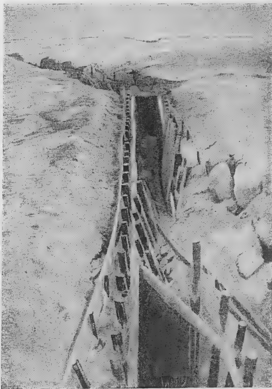
Рис. 110. Траншея с одеждой крутостей, находящаяся в зоне средних разрушений
